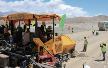
高海拔电动工程车辆施工
