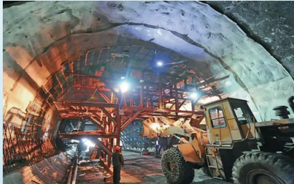
隧道内电动工程车辆施工
