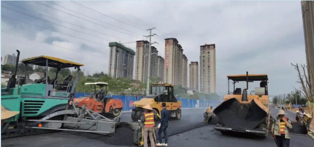
城市内电动工程车辆施工
